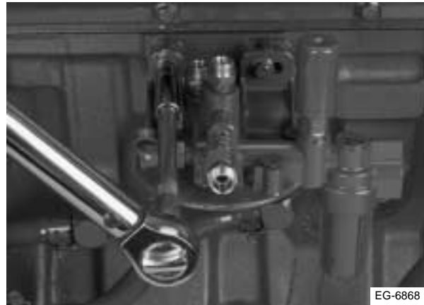
Figura 13.11 Instalación del cabezal del filtro
