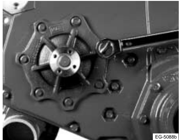
Figura 10.5 Instalación de la bomba de agua
