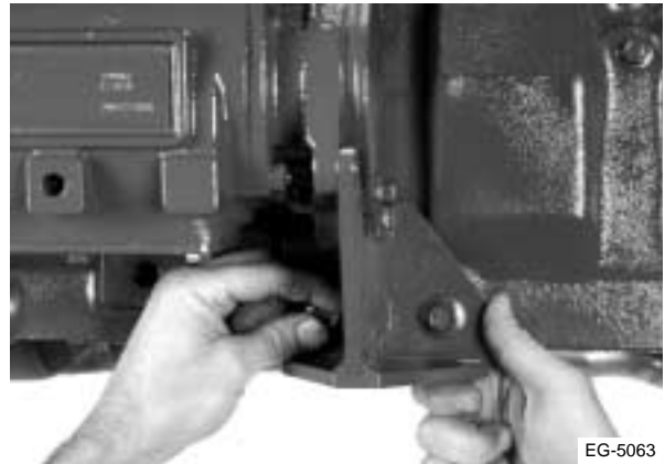
Figura 8.31 Instalación del soporte trasero del compresor de aire
