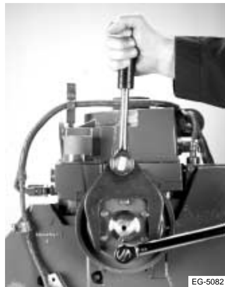
Figura 8.37 Instalación de la polea impulsora del ventilador
