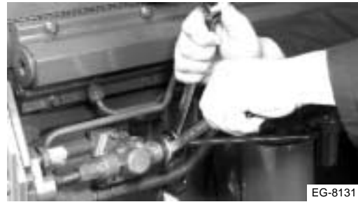
Figura 13.4 Retiro de la tubería de suministro
