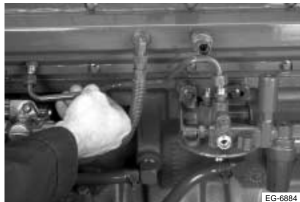
Figura 13.13 Instalación de la tubería del cabezal del filtro al múltiple de suministro
