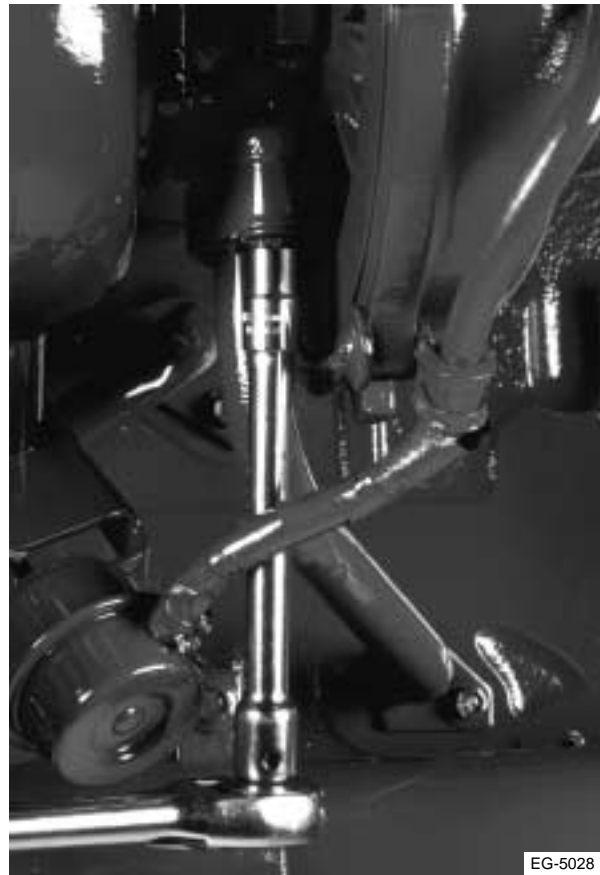
Figura 2.27 Instalación del tubo de drenaje de aceite
