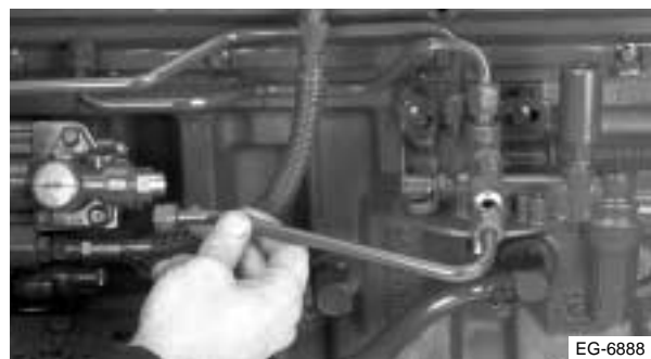
Figura 12.27 Instalación de la tubería de suministro de combustible
