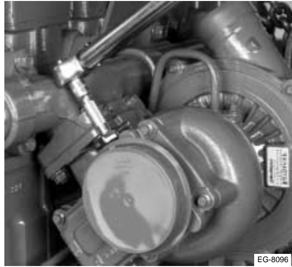
Figura 2.24 Instalación del turboalimentador
