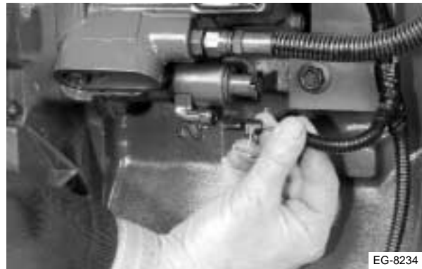
Figura 12.12 Retiro del haz de cables del IPR
