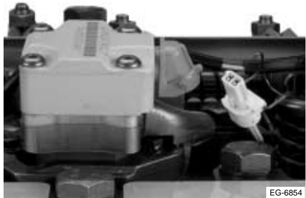
Figura 4.94 Instalación del haz de cables en cada solenoide
