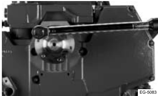
Figura 8.36 Instalación del núcleo impulsor del ventilador
