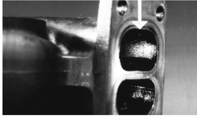
Revisión de lumbreras de entrada de envuelta de la turbina
